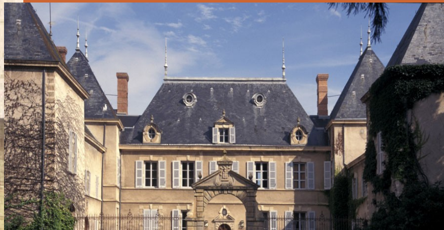
Château Dans le Rhône France
